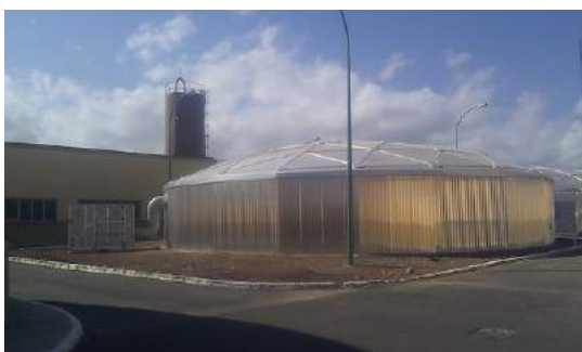
Fig 2: ejemplo cubrición total de un decantador
