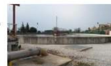
Las instalaciones de la depuradora se encuentran a pocos metros del núcleo urbano de Rincón de la Victoria.
