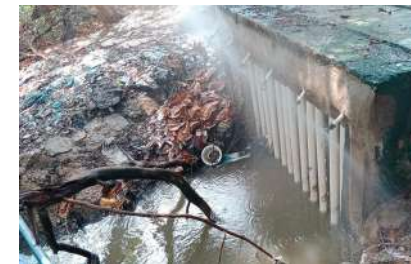
Sistema de Dosificación Para Vertimientos de emergencia
